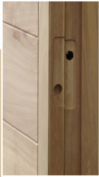
Fresado para bisagras Milling for hinges Preparation pour charnières
